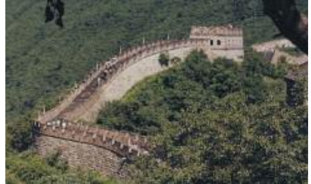
La Gran Muralla China, data desde hace unos 2,200 años, fue construida como un muro de retención de doble lado. El suelo entre los dos muros, fue una mezcla de arcilla y grava reforzada con ramas de Tamariz (Cedro Salado). Los muros Allan Block emplean una "Tecnología antigua con materiales nuevos."
