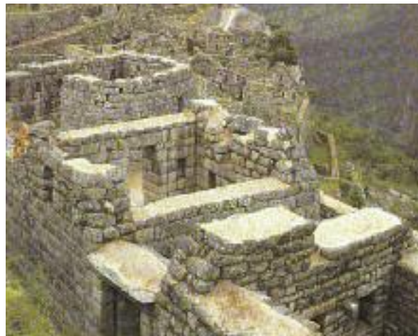
La construcción sin mortero ha sido usada por siglos.
